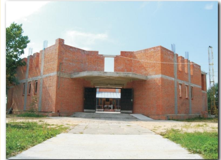
Состояние строительства Святилища в июне 2008 г. – (вид передней части здания).
