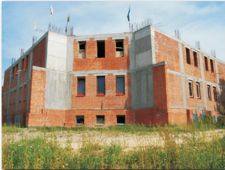
Состояние строительства Святилища в июне 2008 г. – (Вид задней части здания).
