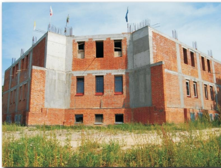
Stan budowy Sanktuarium na czerwiec 2008 r. – (widok z tyłu).
