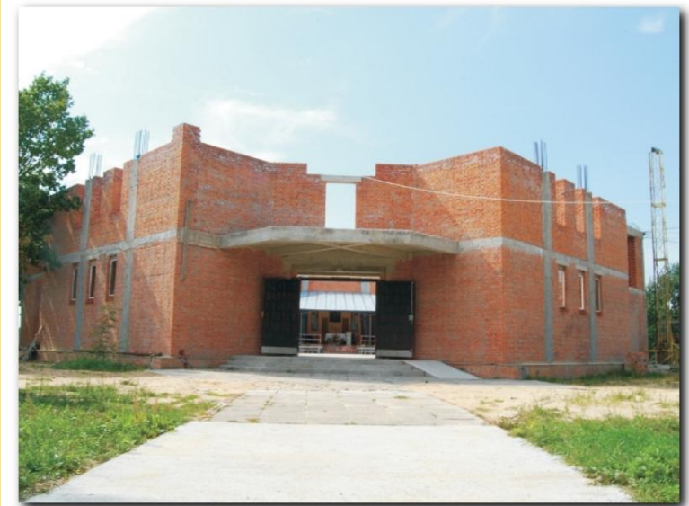
Stan budowy Sanktuarium na czerwiec 2008 r. – (widok z przodu).
