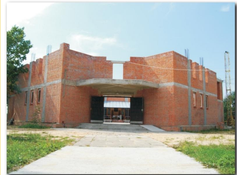
Lo stato di costruzione del santuario in giugno 2008 – (vista davanti).
