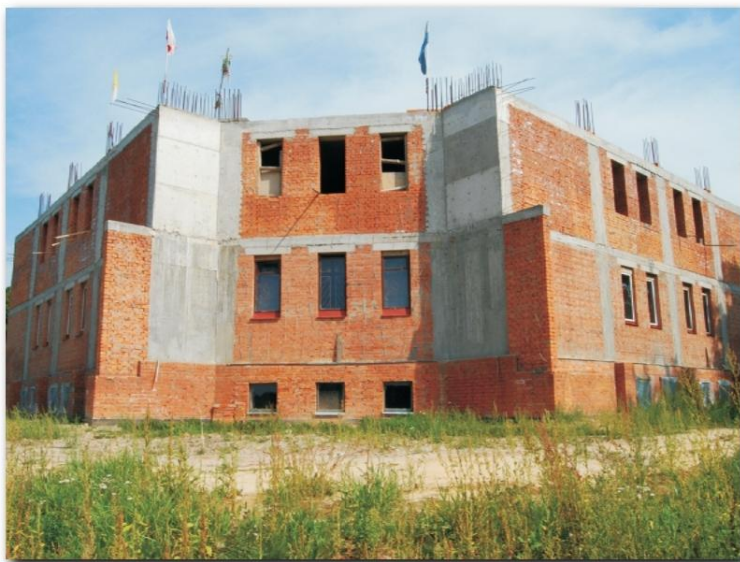
Lo stato di costruzione del Santuario in giugno 2008 – (vista di dietro).
