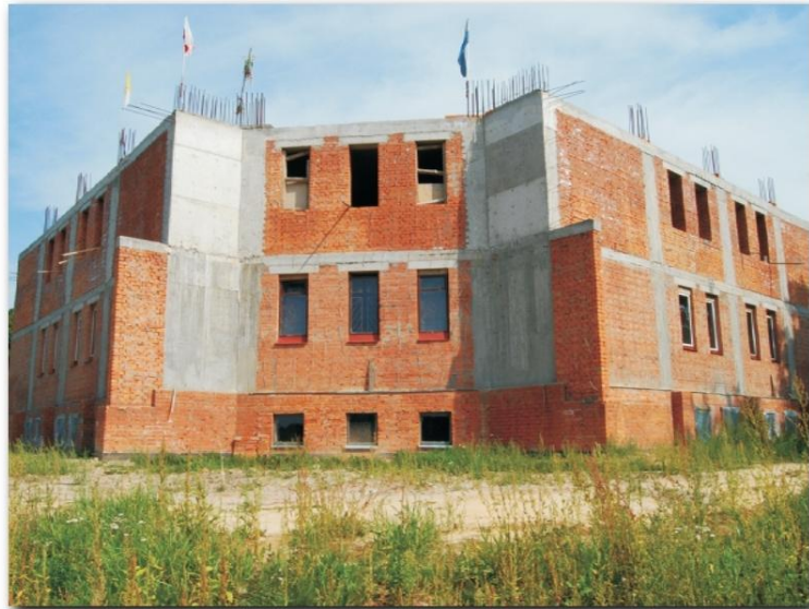
La construction du Sanctuaire en juin 2009 (la partie postérieure).
