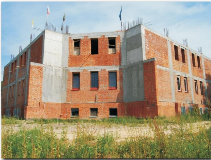
La construcción del Santuario en junio 2009 (la parte posterior).
