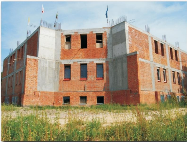
Wallfahrtskirche – Bauzustand im Juni 2008 (Ansicht von hinten).
