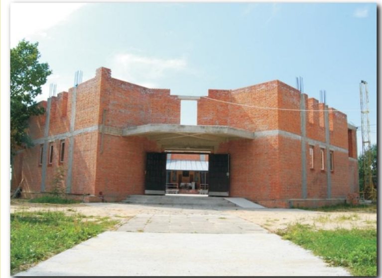
Wallfahrtskirche – Bauzustand im Juni 2008 (Frontansicht).
